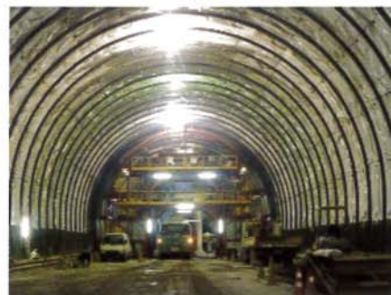
トンネルの防水
