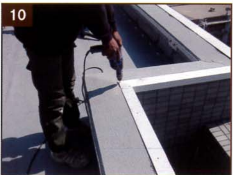
10 (POLYFIN 専用鋼板取付け)
