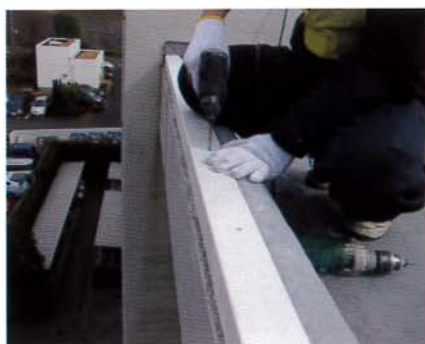
POLYFIN専用鋼板の取付け
