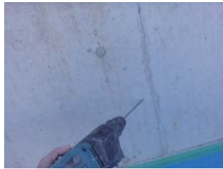
①穿孔： クラックに対し 45 度の角度に 穿孔します
