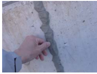
②目止め： クラック内に樹脂の充填を高める ため早強モルタルで目止めします
