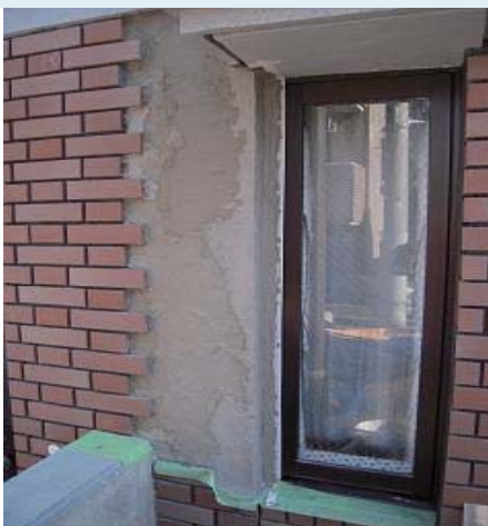
NB エラスティックで防水
