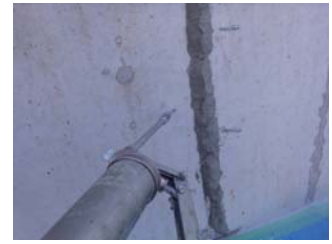
④注入： 市販のグリスポンプで注入をします。 クラックが充填されると目止めの脇 から樹脂が漏出します
