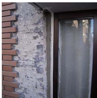
開口まわりのタイル、シール材を撤去
