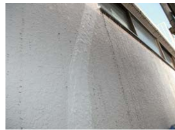
2層目塗布/防水完了
