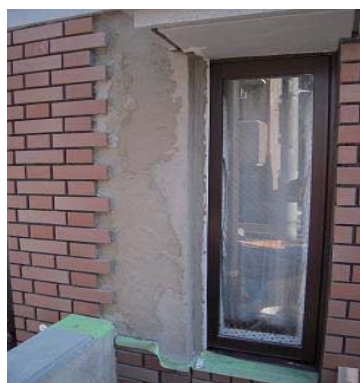
NB エラスティックで防水
